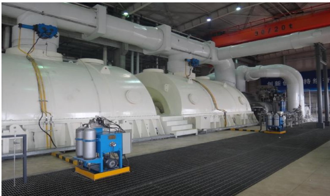
电液执行机构现场安装照片
