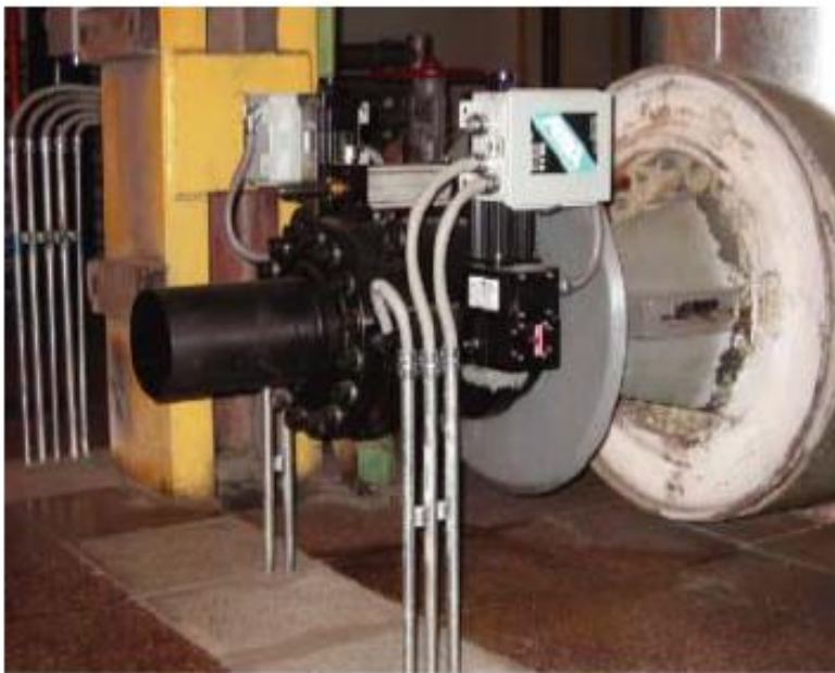
汽轮机旁路调节阀电液执行机构
