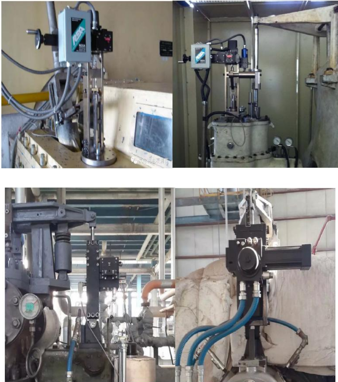
汽轮机 REXA 执行器 DEH 系统现场安装照片
