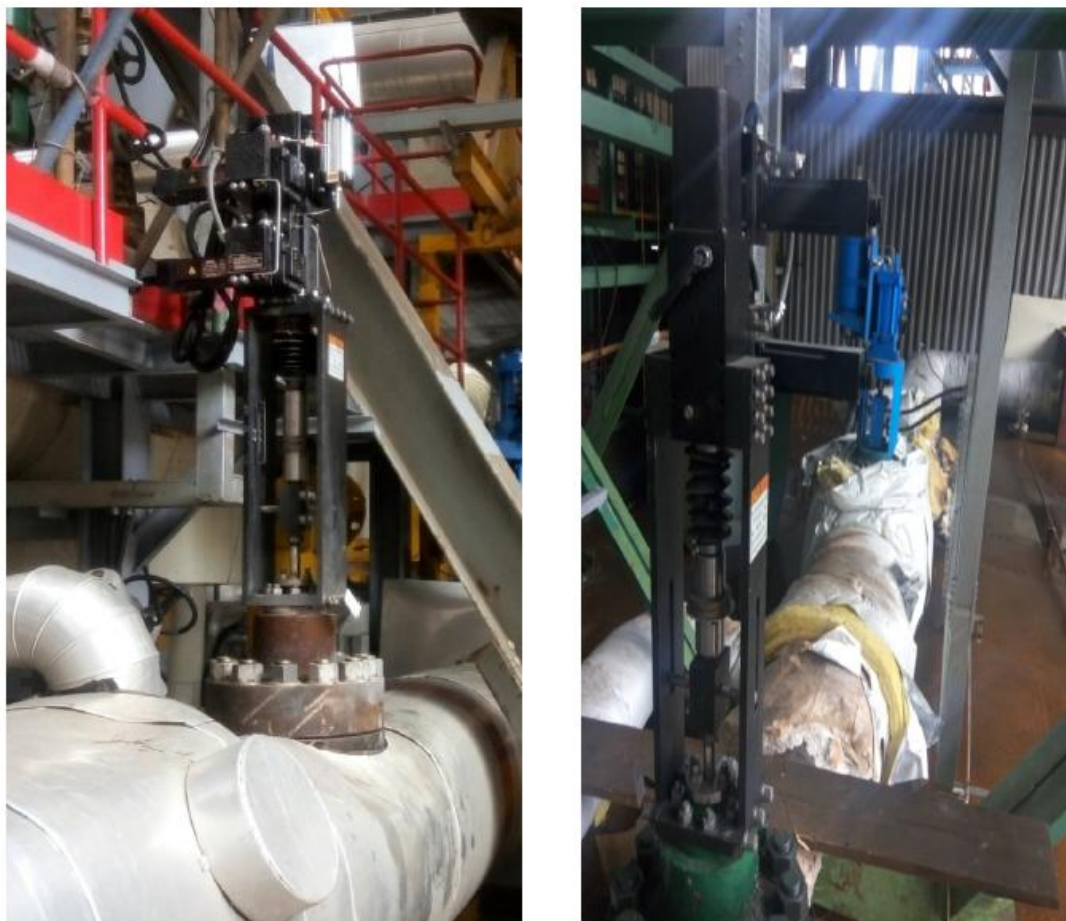
图 2 REXA 电液执行器调节阀和快速关断阀
